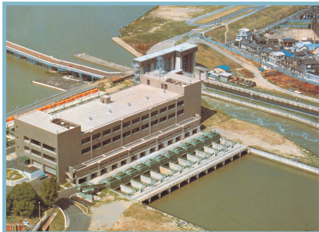
Kema Pompa İstasyonu : Büyük ve prestijli drenaj projelerinden birtanesi olan bu istasyon, tamamı ile EBARA' nın bu tip pompa istasyonu sistemleri ve bu konudaki know-how'ı kullanılarak yapılmıştır.
